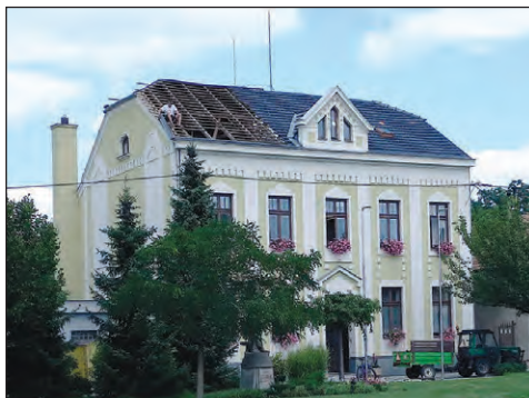
Začátkem srpna byla zahájena rekonstrukce střechy na budově obecního úřadu.
