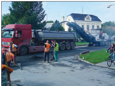
Na konci září probíhaly intenzivně práce na opravě průtahu Smržicemi.
