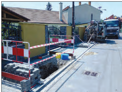
Rekonstrukce mostu mezi ulicí Zákantí a Koupelky začala přeložením plynovodu.
