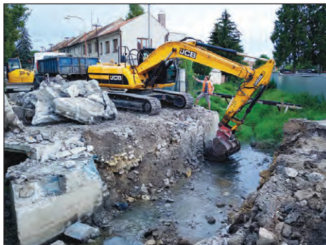
Po kolaudaci přeložky plynovodu mohla v polovině září začít demolice mostu.
