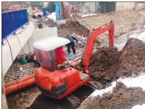
Pracovníci stavební firmy se pustili do dokončovacích prací na novém mostě.
