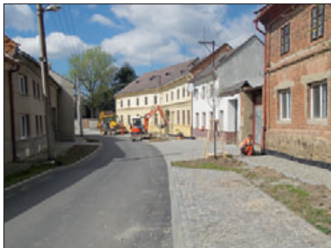
V polovině dubna bylo budování chodníků a odstavných ploch na Podhájí v plném proudu a dokreslilo novou tvář této opomíjené ulice.
